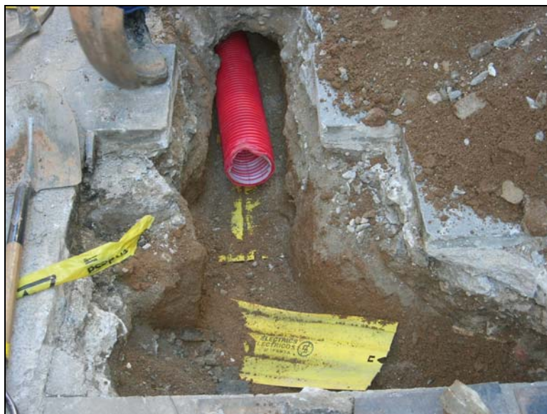
3. Tub ja col·locat, s'aprecia per sota del mateix una placa de protecció d'una línia anterior.
